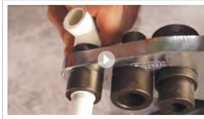
Монтаж полипропиленовых труб.
